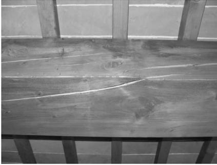
Figura 1.9: Trave con fessura che attraversa lo spigolo.
