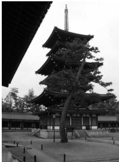
Figura 2.37: Pagoda in un tempio Giapponese. Come l'albero che le sta davanti, la pagoda è in grado di resistere flettendosi e oscillando a terremoti devastanti senza crollare e spesso senza nemmeno subire danni rilevanti.
