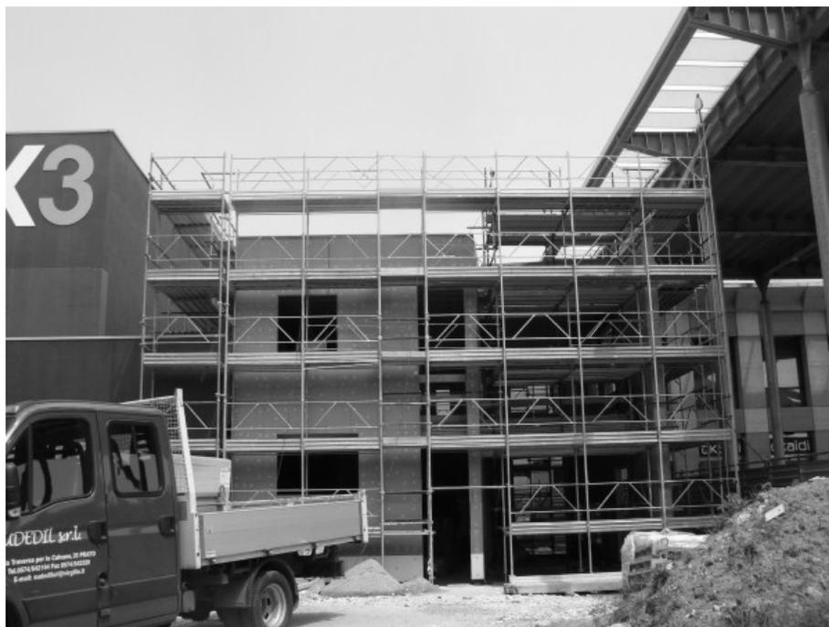
*Figura 1.2: Edificio di due piani a Firenze destinato ad ospitare una ludoteca, interamente realizzato con pannelli strutturali di legno toscano.*
