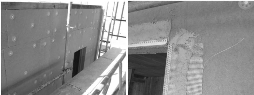
Figura 3.4 L'edificio, realizzato con struttura a pannelli di legno massiccio a strati incrociati, è rivestito con pannelli di fibra di legno aderenti alla struttura; il successivo strato di intonaco rende la superficie non infiammabile e impedisce la propagazione del fuoco in facciata.
