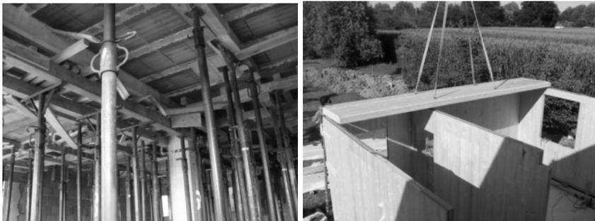
*Figura 2.1: Confronto fra la realizzazione di un solaio in latero-cemento e quella di un solaio in legno. Per il primo occorre puntellare, posare il solaio, cassarare le travi, effettuare il getto, aspettare la maturazione del getto e disammare il solaio. Per il secondo, una volta montate le pareti al piano terra, basta posare i pannelli del solaio e collegarli alle pareti sottostanti e fra loro con l'utilizzo di semplici viti.*
