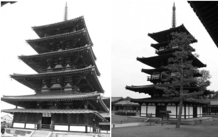
Figura 2.2: Due pagode giapponesi interamente in legno e con altezze di circa 30m, entrambe situate a Nara, l'antica capitale del Giappone, vicino a Kyoto. La prima, situata nel tempio di Horyu-ji è stata costruita nel 607 d.C., la seconda, situata nel tempio di Hokekyu-ji costruita nel 784 d.C.
