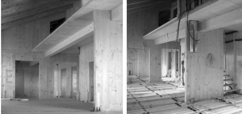
Figura 4.2: Casa per civile abitazione, spazi interni definiti dagli elementi strutturali in pannelli di legno portanti ed integrazione tecnologica di pavimento radiante (Casa Mazza, Linguaglossa, Catania).
