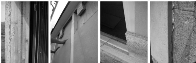
Figura 4.2: Diverse tipologie di cappotto esterno per edifici in legno a pareti portanti.
